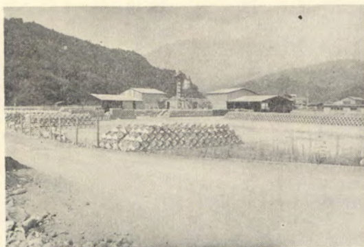
早川橋付近の工場（ブロック工場）
