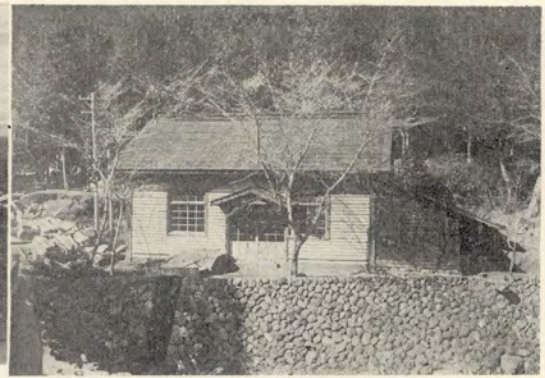
西谷発電所全景
