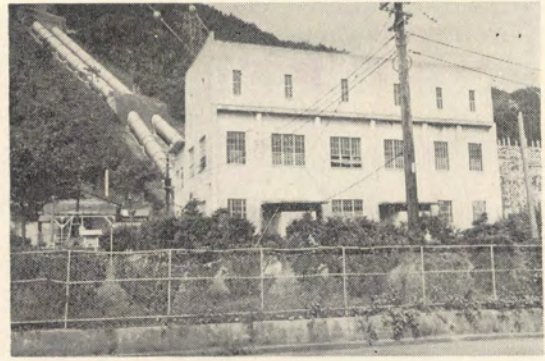
軽金波木井発電所
