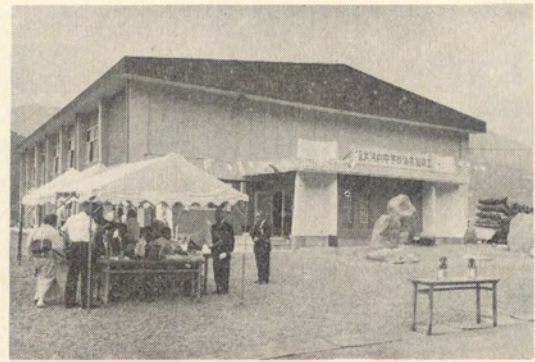
44年9月竣工の大河内中体育館
