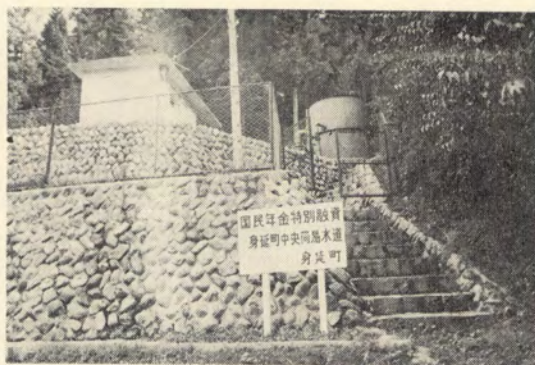
中央簡易水道浄水場
