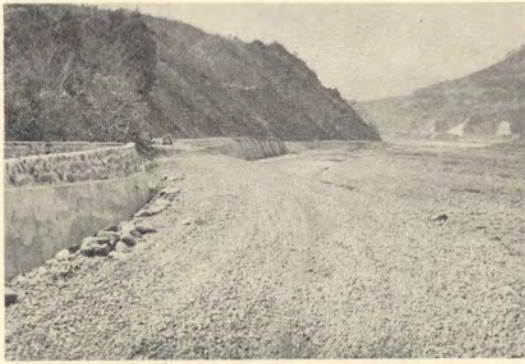
下八木沢地内の県道(西八代縦貫道路の工事中)
