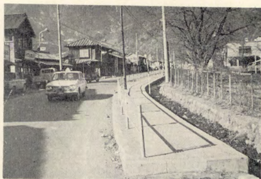
身延高校前の国道52号線歩道
