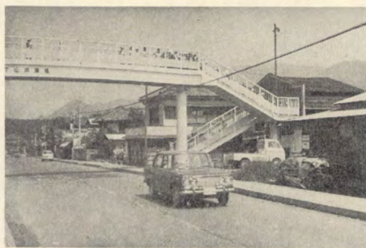
下山小学校前の歩道橋
