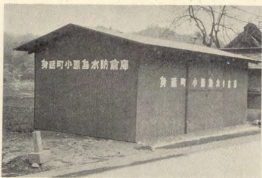
下山小原島の水防倉庫
