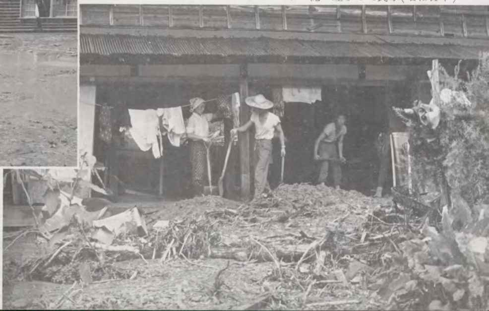
▼ 泥に埋まった民家(昭和41年)
